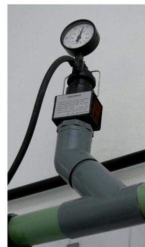
é mantido pela entrada de ar através de sua válvula. Sempre que houver entrada de ar por meio de outro componente do sistema, a válvula do regulador de vácuo fecha-se, para tentar manter o nível de vácuo constante. Ele controla a velocidade de rotação da bomba de vácuo, de forma que haja produção somente para a quantidade necessária de vácuo.
